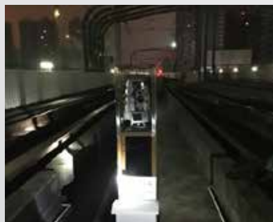
地铁高架段监测
